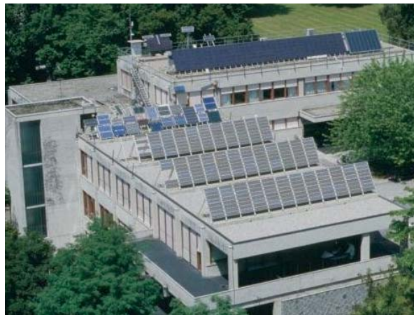
Panoramica dell'impianto TISO 10 kW SUPSI-LEEE.
